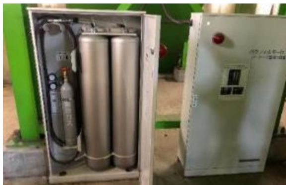
図 5-10 沼上清掃工場に設置された延焼防止設備
